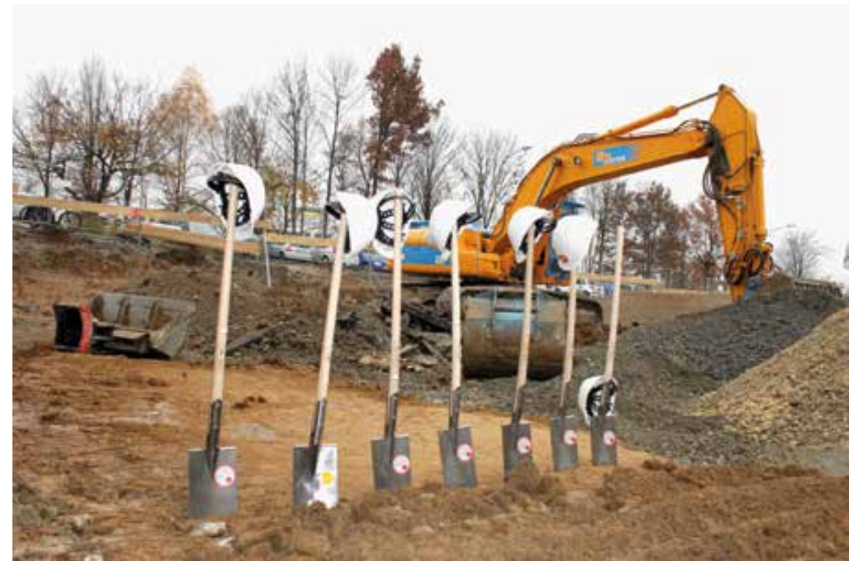
Der Spatenstich zum Neubau
