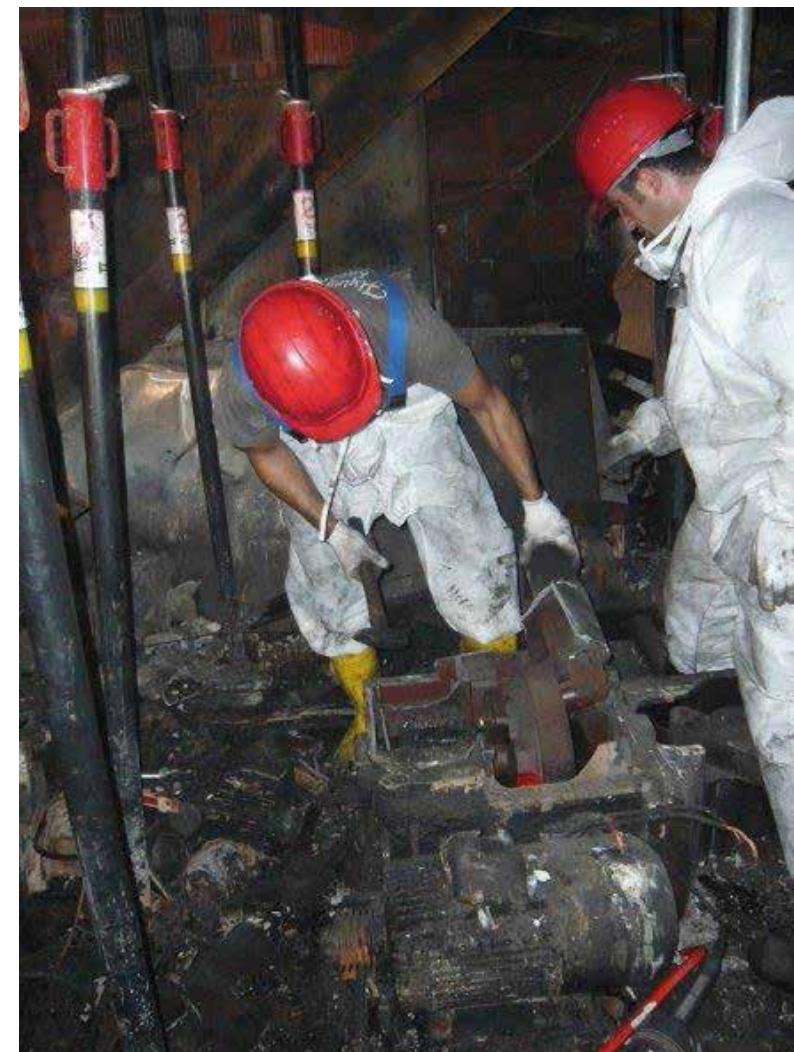
Monteure beim Zerlegen der zerstörten Maschinen. Nur so war das einsturzgefährdete Gebäude sicher zu evakuieren
